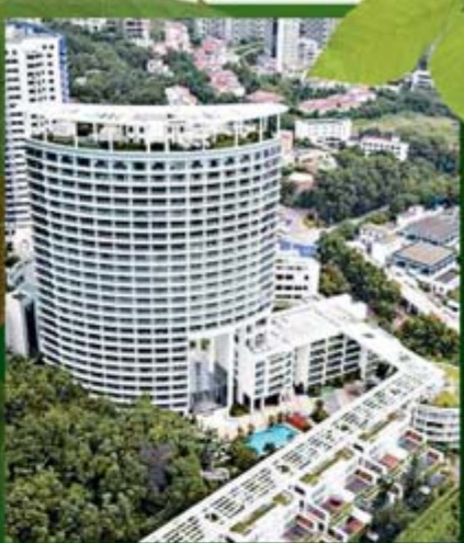
■深圳的泰格公寓是中國首幢獲得LEED認證的商業建築。
