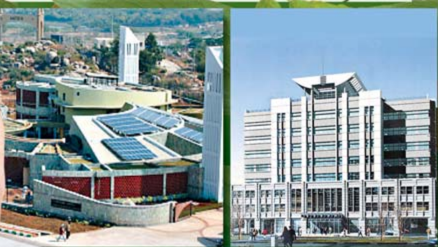
■印度CII-Godrej綠色商務中心大樓是當地首幢綠色建築。
